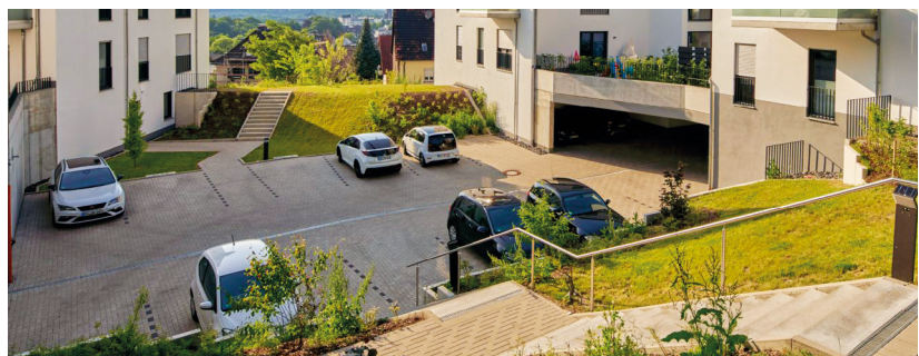
Abbildung 6: Wohnanlage mit konzentrierter oberirdischer und teilweise in den Hang eingelassener Stellplatzanlage in Arnsberg-Neheim. Quelle: Arnsberger Wohnungsbaugenossenschaft eG, 2016.
